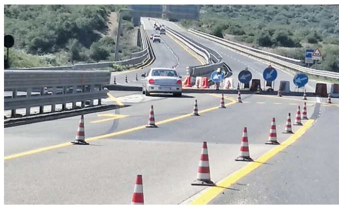
Il viadotto sull'Omodeo nel punto dove la carreggiata si riduce
